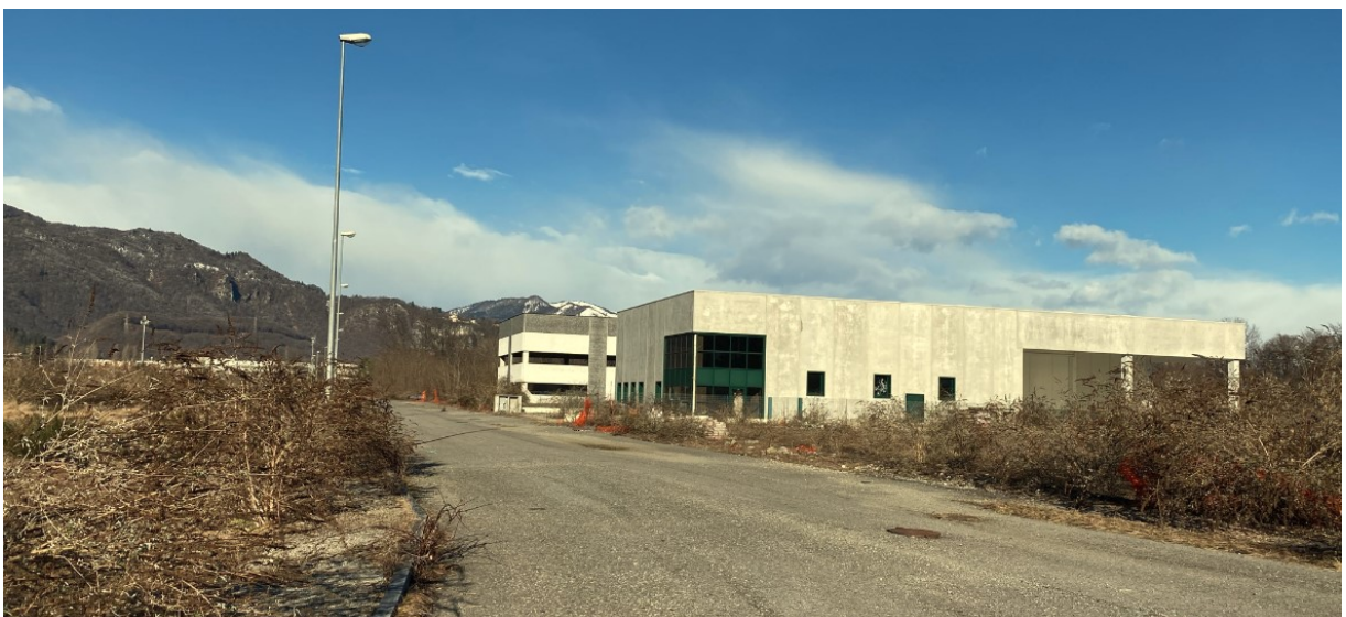
Edifici produttivi parzialmente realizzati e asse viario principale
